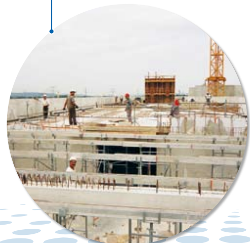
préparation des planchers avant mise en œuvre du revêtement final
